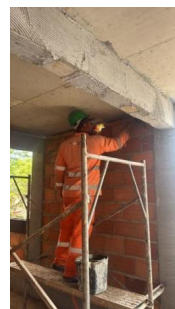
06/02/2026 - Encunhamento de alvenaria
