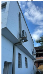
06/02/2026 - condutor de agua pluvial
