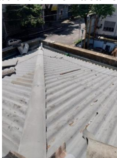
06/02/2026 - Telhas e Espigao em fibrocimento
