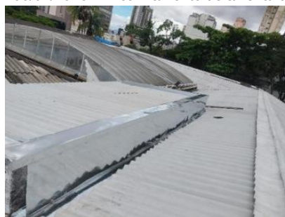
06/02/2026 - Telhado calha e rufo
