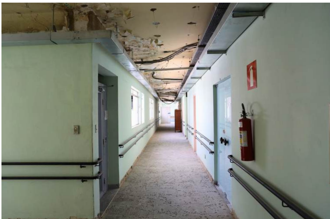
Imagem 9 – Obras na Sede da ESP (Créditos: Karen Ferreira/Ascom/ESP-MG)
